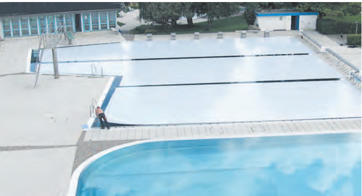
Das Erlebnisbadteam wird in die Technik eingewiesen, die Abdeckung nach dem Badebetrieb als Wärmeschutz auszurollen und morgens vor dem Badebetrieb wieder einzuholen.
