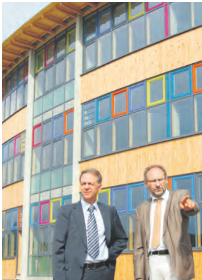
Stadtbaumeister Matthias Distler (rechts) und Bürgermeister Johannes Moser vor dem fast fertigen 2. Bauabschnitt des Engener Gymnasiums.
