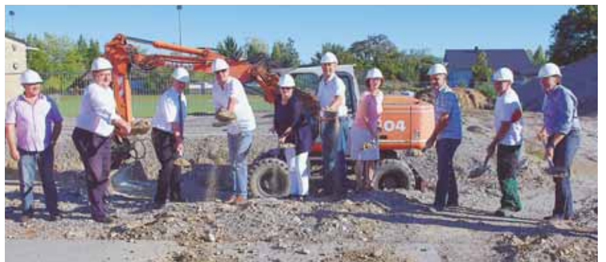
Mit vereinten Kräften von Planern und Lokalpolitikern wurde am Montag der erste Spatenstich an der neuen Halle in Büsingen vollzogen. Die alte Halle wurde vor einem Jahr durch eine Brandstiftung schwer beschädigt. subb-Bild: of
