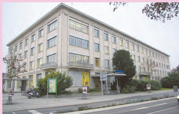
Optisch sieht man kaum etwas von den neuen Fenstern im Singener Rathaus. Sichtbar wird die Sanierung aber auf jeden Fall in der Energiebilanz. swb-Bilder: of
