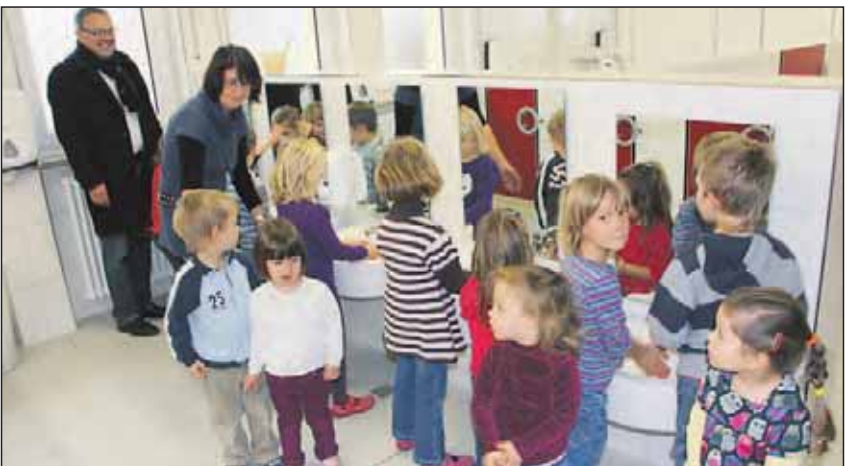
Die erste Sanierung seit 1974: Der Kindergarten in Ehingen hat neue Sanitäranlagen bekommen. Die Waschbecken sind auf der richtigen Höhe für Kinder, die Toiletten ebenfalls, außerdem gibt es eine Dusche und einen hellen, gefliesten Raum zum Mantschen. 45.000 Euro hat der Umbau gekostet. 30.000 davon stammen aus dem Wilhelm-Beising-Vermächtnis, den Rest hat die Gemeinde dazugegeben.
