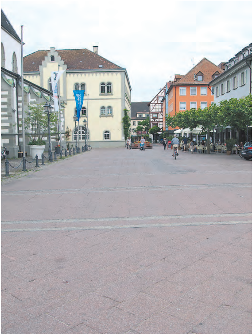
Die Platten auf dem Marktplatz müssen saniert werden. Zukünftig sollen hier außerdem weiße oder anthrazitfarbene Pflanzenkübel stehen, in der restlichen Altstadt apfelgrüne.
