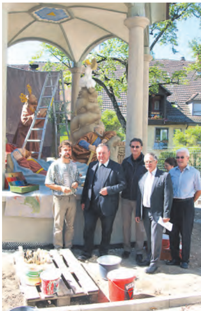
Über den bevorstehenden Abschluss der Restaurierungsarbeiten freuen sich (v.l.) Restaurator Robert Lung, Pfarrer Michael Hauser, Architekt Martin Frei und die Vorsitzenden des Münsterbauvereins, Helmut Villinger und Rainer Alferi. swb-Bild: Kempf
