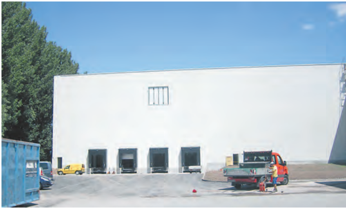
Das neue Produktionsgebäude der Firma Hügli wurde eingeweiht.
