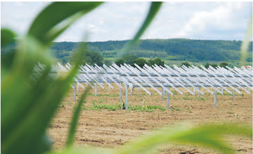
Die Unterkonstruktion wartet auf die Modulmontage. Die Solaranlage beim Mooshof soll im August in Betrieb genommen werden.
