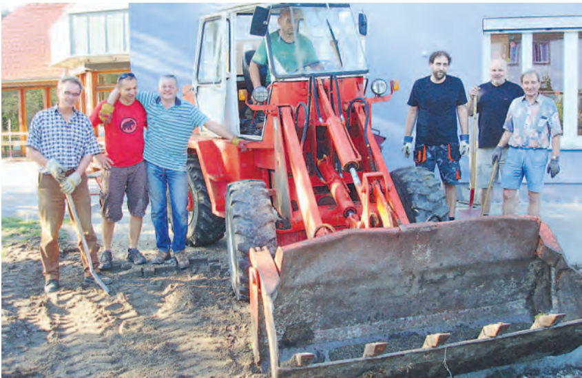
Gemeinsam für die Kleinsten: Mit vereinten Kräften und großem Gerät versetzen die Liggeringer Helferinnen und Helfer den Außenbereich des umgebauten Kinder- gartens in einen spielgerechten Zustand. Über 150 ehrenamtliche Stunden wur- den geleistet. swb-Bild: Ortsverwaltung Liggeringen
