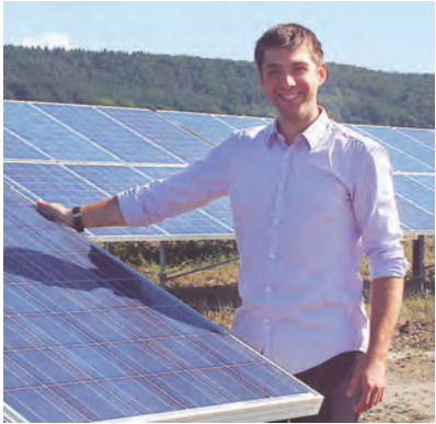
Etwa eine Million Kilowattstunden Solarstrom wird die Anlage beim Mooshof pro Jahr erzeugen, verspricht Projektleiter Maximilian Mayr von den Stadtwerken.
