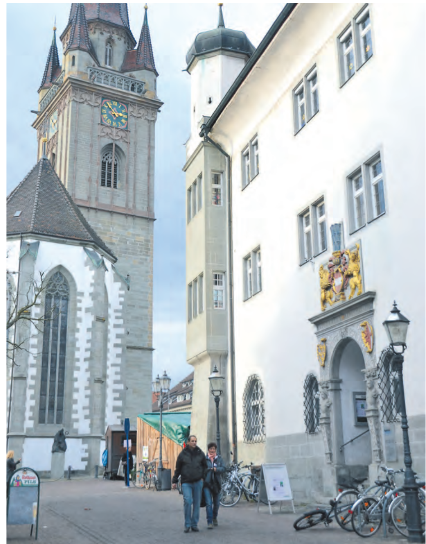
Ein Dauerbrenner im Radolfzeller Gemeinderat: Mit der Sanierung des Österreichischen Schlösschen soll im kommenden Jahr endlich begonnen werden. Das voraussichtliche Ende der Bauarbeiten ist auf 2014 terminiert. Spätestens dann kann sich die städtische Bibliothek auf ein rundum saniertes Zuhause freuen.
