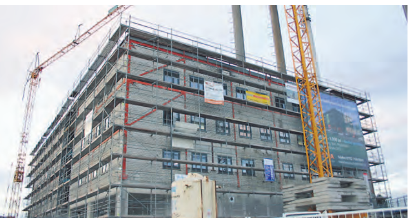
Das ehemalige Kesselhaus der Schiesser AG wird derzeit zu einem modernen Unternehmensstandort umgebaut. Die ersten Firmen werden im kommenden April einziehen. swb-Bild: pud
