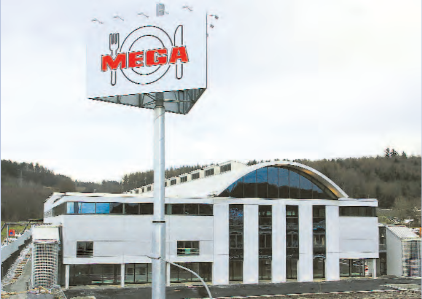
Am Reichenau-Ring 1 im Gewerbegebiet »Blumhof« ist der »MEGA«-Neubau mit einer Nutzfläche von etwa 12.125 Quadratmetern entstanden.
