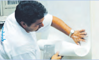
Eine neue Folie kann bei der Renovation Fassadenrisse bis zu 5 Millimeter Stärke überbrücken.
