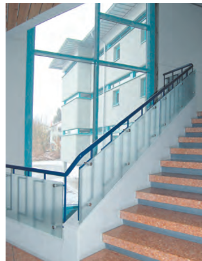
Brandschutzmaßnahmen müssen im Rathaus erfolgen. swb-Bild: Weiß
