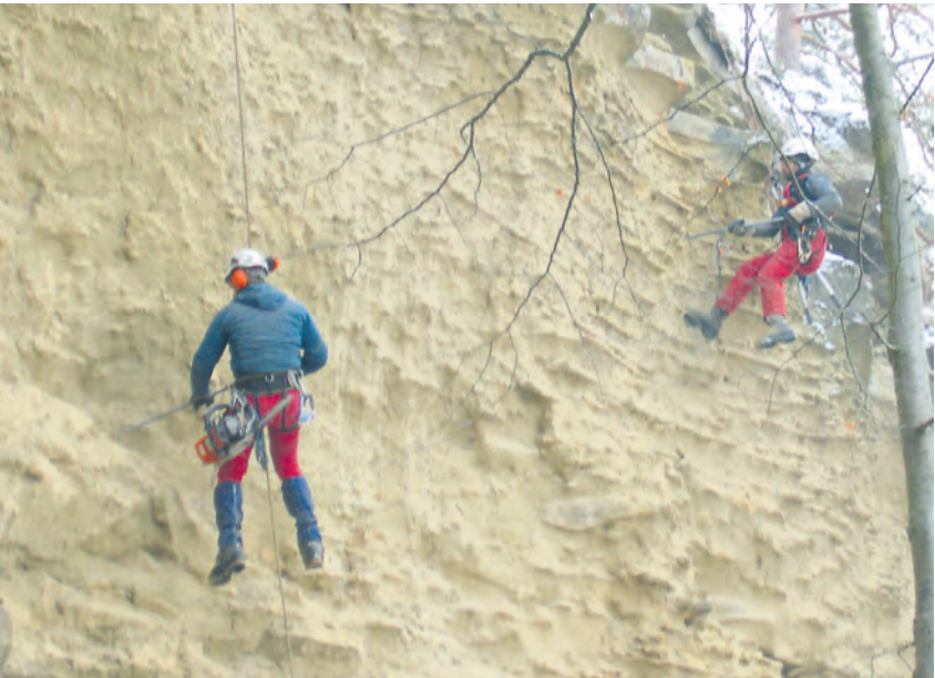
Verkehrssicherheit und Naturschutz im Blick: Ein Spezialteam befreit die Felsen bei den Heidenhöhlen von losem Gestein und lockeren Felsplatten.
