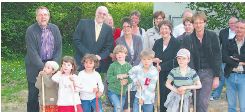
Ihnen soll der Neubau zugutekommen: Die Kleinsten helfen Bürgermeister Rainer Stolz, Stephan von Werthern und Architekt Christian Remes beim ersten Spatenstich.
