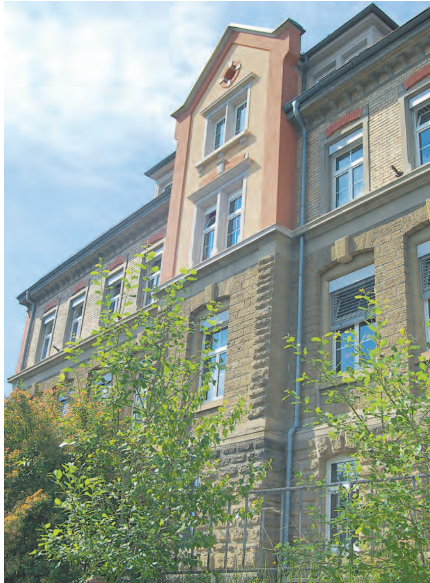
Die Kombinationsklasse fünf und sechs der Anton-Sohn-Schule in Zizenhausen soll nach Stockach verlegt werden. Der Grund – zu geringe Schülerzahlen. Die Grundschule verbleibt aber weiterhin in dem Ortsteil. swb-Bild: Weiß
