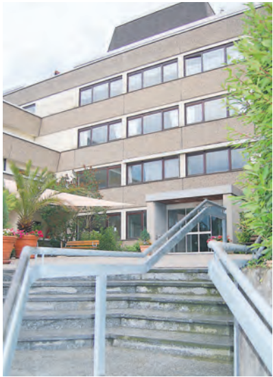
Das Seniorenheim in der Zoznegger Straße soll abgerissen und durch einen Neubau ersetzt werden.
