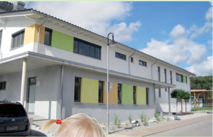
Im Erweiterungsbau der Schule Eigeltingen sind eine Mensa mit Küche im Erdgeschoss und Klassenzimmer für Grundschüler im Obergeschoss untergebracht.
