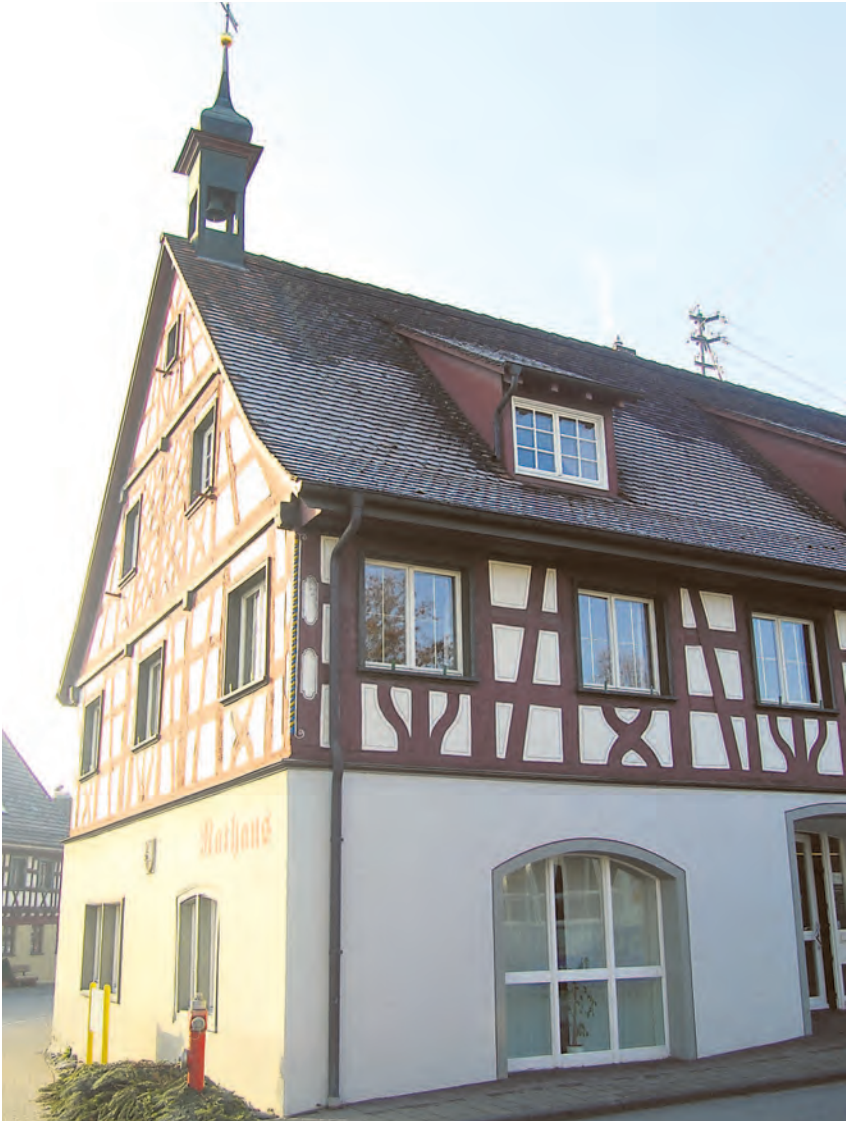
Das Eigeltinger Rathaus an der Krumme Straße erhält einen Anbau für Kosten in Höhe von 1,6 Millionen Euro. Start wird im Sommer 2012 sein, die Baumaßnahme soll bis Dezember 2013 abgeschlossen sein. sub-Bild: Weiß
