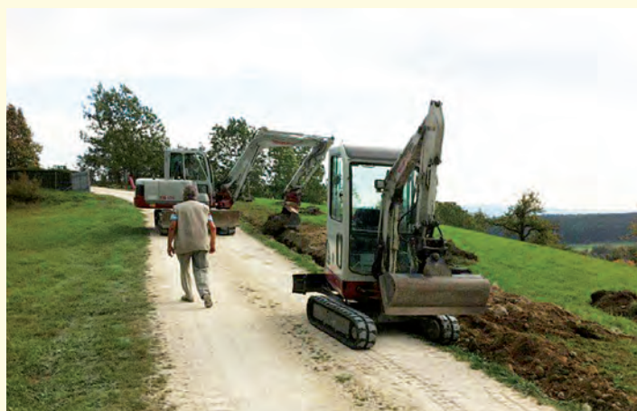
Die Verlegearbeiten der Mittelspannungsleitung sind in den nächsten Tagen beendet
