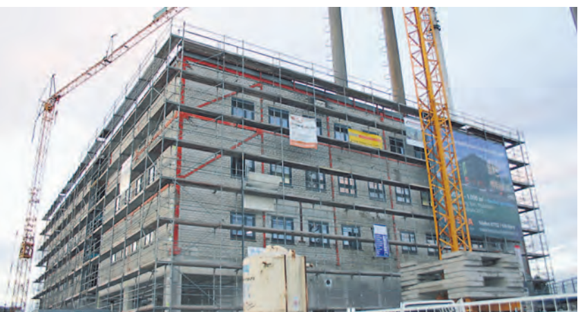
Das ehemalige Kesselhaus der Schiesser AG wird derzeit zu einem modernen Unternehmensstandort umgebaut. Die ersten Firmen werden im kommenden April einziehen. swb-Bild: pud
