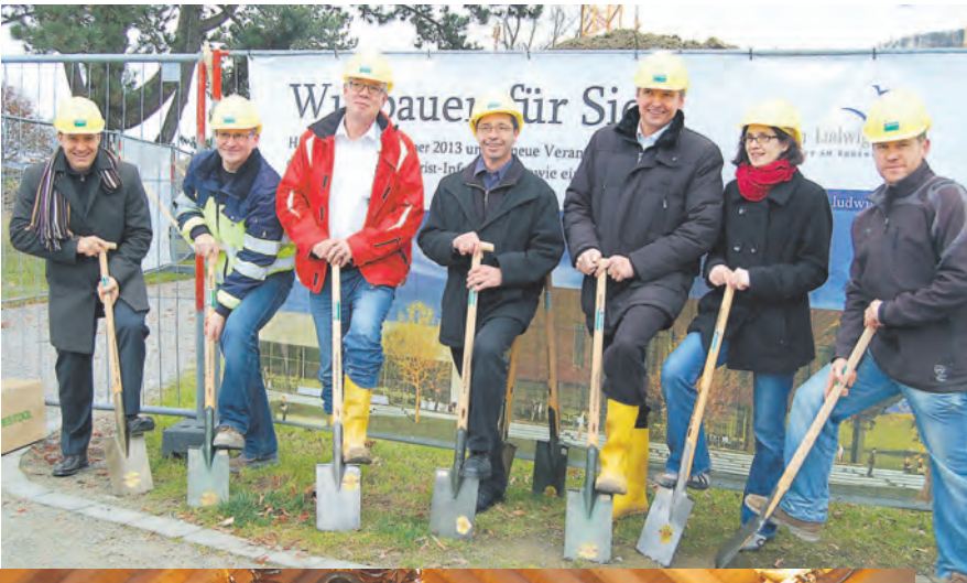
Endlich: Nach langem Bangen und dem Abriss von Obsthalle und Rathaus ist der erste Spatenstich zur neuen Ortsmitte von Bodman erfolgt.
