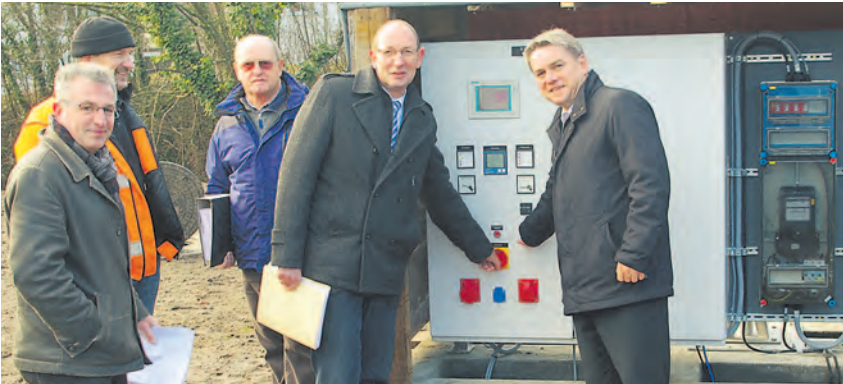
Das neue Regenüberlaufbecken am Arlener Lindenplatz ist in Betrieb gegangen: Im Bild der Mooser Bürgermeister Peter Kessler, sein Kollege Ralf Baumert aus Rielasingen, Tiefbauamtsleiter Rolf Mahlbacher, Johannes Stulz und Betriebsleiter Peter Merk.
