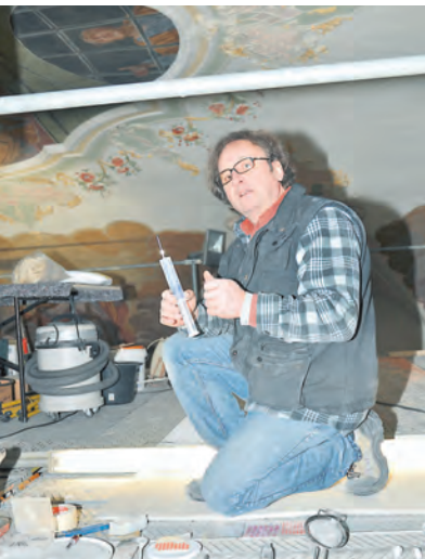
Injektionen für den Deckenputz: Restaurator Bauer bei der Arbeit in der Stadtkirche Engen. swb-Bild: Stadtbauförderverein
