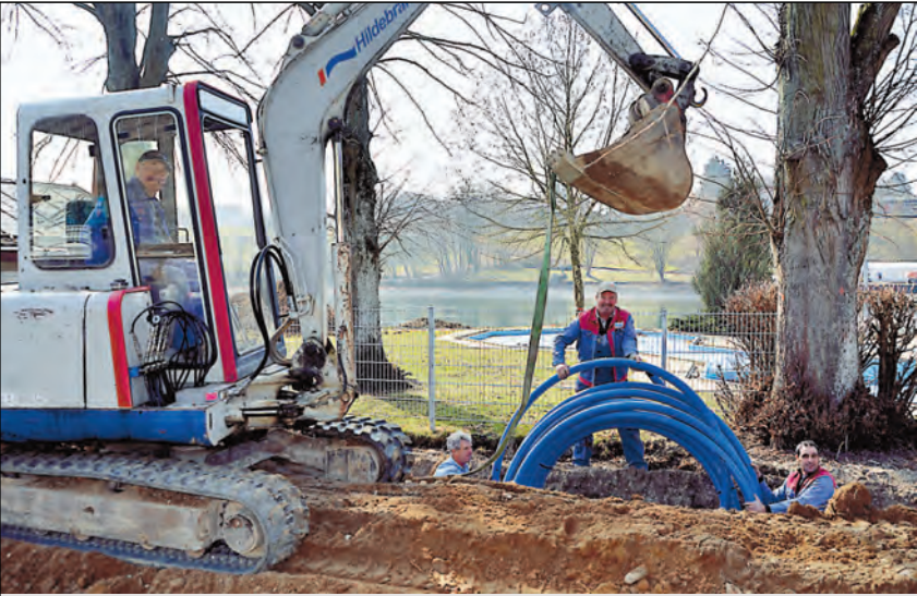
Die Bauarbeiten im Rheinuferpark in Gailingen sind in vollem Gange. Die Mitarbeiter der Firma Hildebrand aus Bodman-Ludwigshafen verlegen gerade die Trinkwasserleitungen für das Schwimmbad. »Bis zur Sommersaison werden die Arbeiten dieses Bauabschnitts abgeschlossen sein«, freut sich Bürgermeister Heinz Brennenstuhl. Bis dahin gibt es noch einiges zu tun, unter anderem wird noch ein Wasserspielfeld gebaut.
