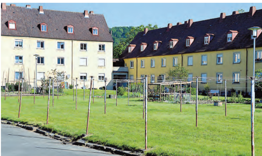
Sanierung und Neubau: Die Gebäude an der Flieder- und Hardstraße stehen im Fokus der diesjährigen Projekte.
