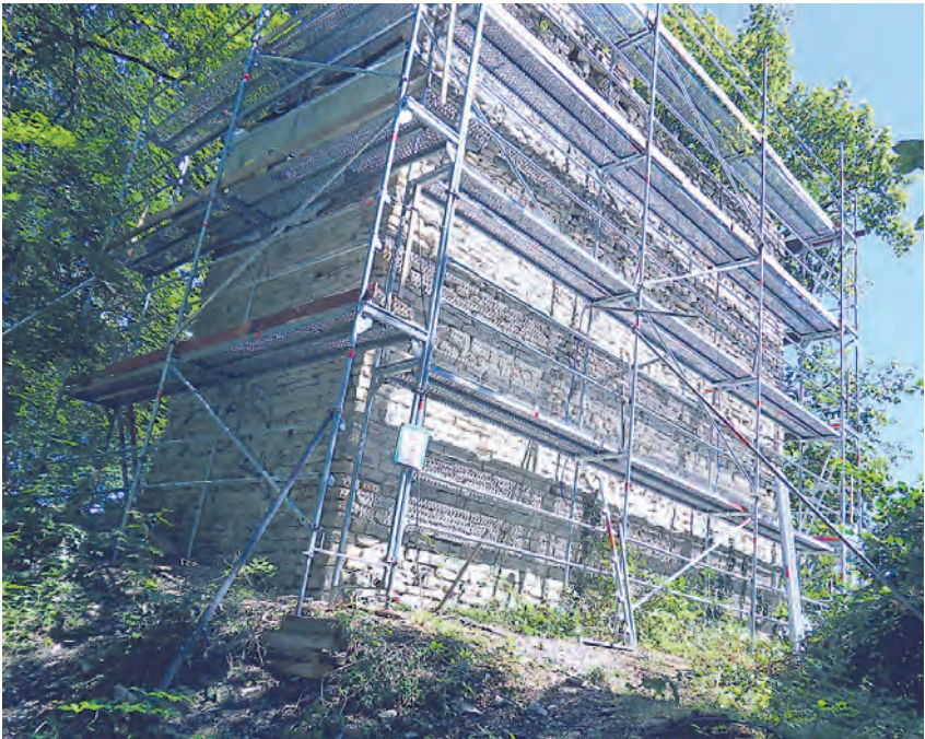
Vor einem Jahr haben die Bauarbeiten begonnen. Wegen immenser Kostensteigerung und einem möglichen Wechsel der beauftragten Firma verzögern sich die Bauarbeiten weiterhin. swb-Bild: Stadt Aach
