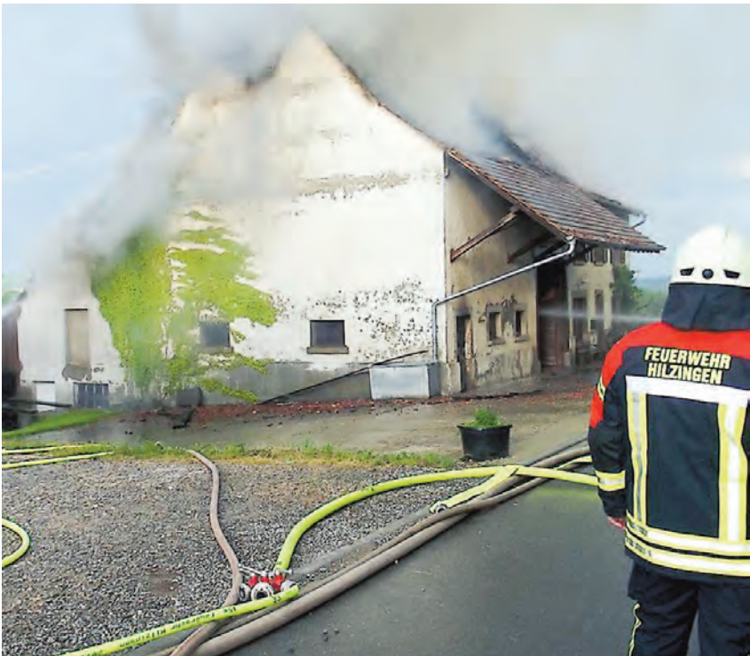
Es gab einen Knall und dann kamen die Flammen. An dem etwa 100 Jahre alten Bauernhaus in Schlatt ein Schaden von weit rund 250.000 Euro entstanden. Teile des Gebäudes stürzten ein.
