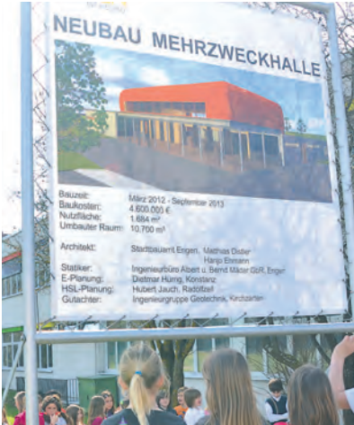
Jetzt wird auf der Baustelle der Mehrzweckhalle richtig Gas gegeben.
