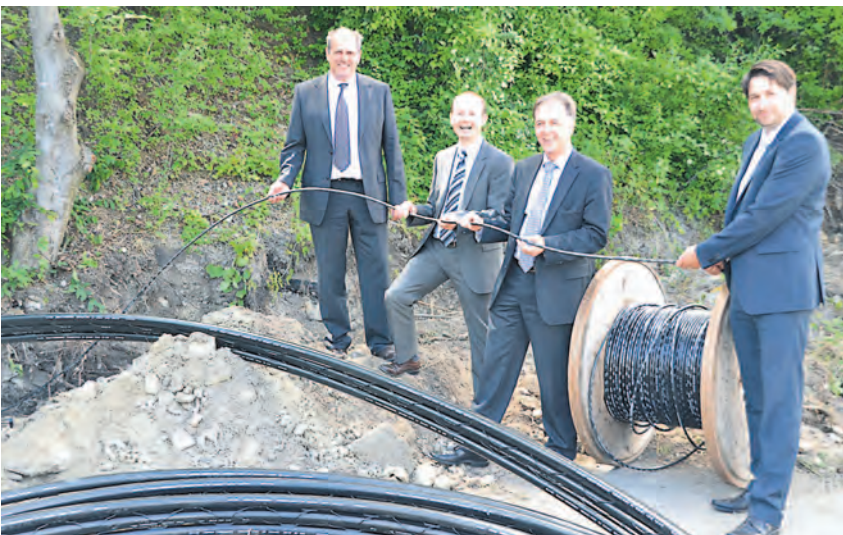
Internet und Telefon bald von den Stadtwerken Engen. Dafür werden jetzt Glasfaserkabel verlegt (von links): TeleData-Geschäftsführer Stephan Linz, Stadtwerke-Geschäftsführer Peter Sartena, Bürgermeister Johannes Moser und Teledata-Geschäftsführer Armin Walter.
