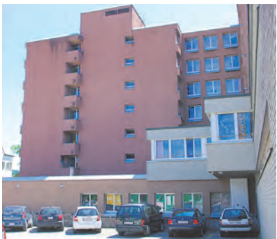
Am Tag der offenen Türe zum 40-jährigen Bestehen des Alterswohnheims wurden die Besucher über die dringende umfassende Sanierung mit Teilneubau informiert. swb-Bild: of
