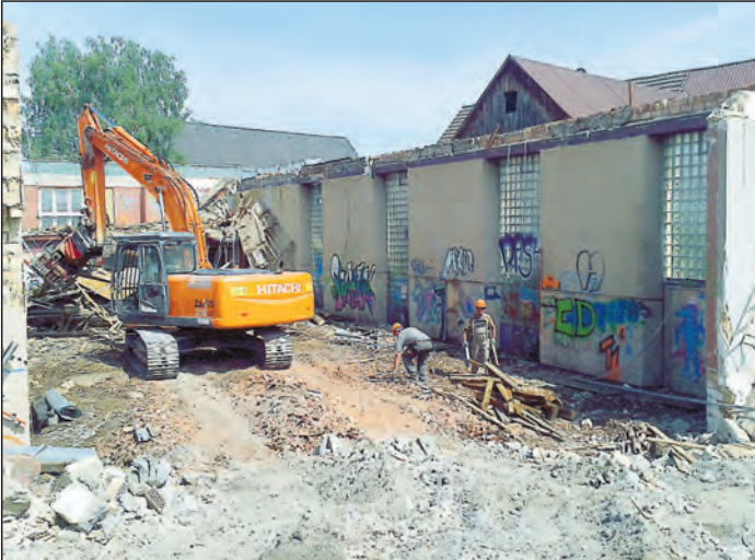
»Hallenlos« ist Rielasingen wohl bald. Denn nächste Woche soll der Rückbau der Rosenegghalle abgeschlossen sein. Die Sporthalle der neuen Talwiesenhalle ,ist allerdings seit einem massiven Wassereinbruch vermutlich bis zu den Sommerferien gesperrt.
