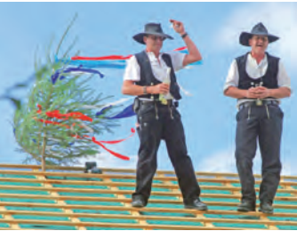
Ganz aus Holz ist der Erweite- rungsbau des Kindergartens St. Sebastian. swb-Bild: of
