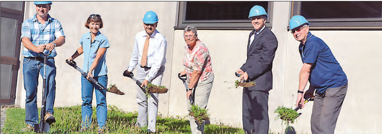
Nun geht ein lang gehegter Wunsch der Welschinger Vereine in Erfüllung: Mit dem Spatenstich am Montag Nachmittag fiel der Startschuss zur Erweiterung und energetischen Sanierung der Hohenhewenhalle. Rund 584.000 Euro wird das Vorhaben kosten, das bis in einem Jahr abgeschlossen sein soll. Ein Zuschuss von 105.000 Euro entlastet die Stadtkasse. Natürlich werden die Welschinger Vereine kräftig mitanpacken; sie waren auch an der Planung mit dem Städtischen Bauamt beteiligt. Besonders engagiert für die Sache haben sich UWV-Stadträtin Irene Völlinger 3.v.re) und Norbert Lauener (re) neben Bürgermeister Moser. Im Bild von links: Bernd Keller, Vereinsvertreter, Ingrid Bantel und Matthias Distler vom städtischen Bauamt.
