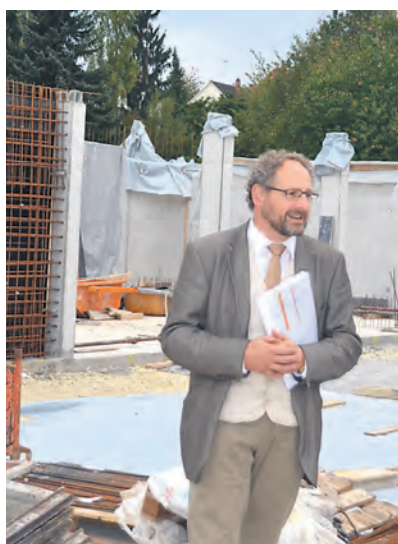
Stadtbaumeister Matthias Distler erläuterte dem Engener Gemeinderat den Baufortschritt der neuen Stadthalle. swb-Bild: mu
