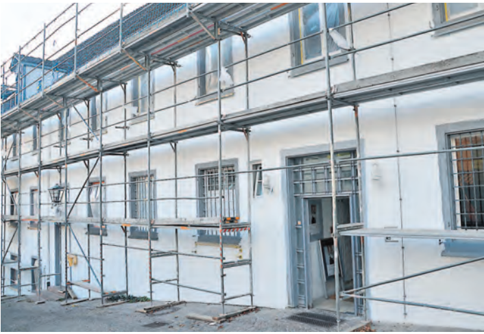
Das ehemalige Kloster St. Wolfgang in der Engener Altstadt wurde außen frisch saniert. swb-Bild: mu
