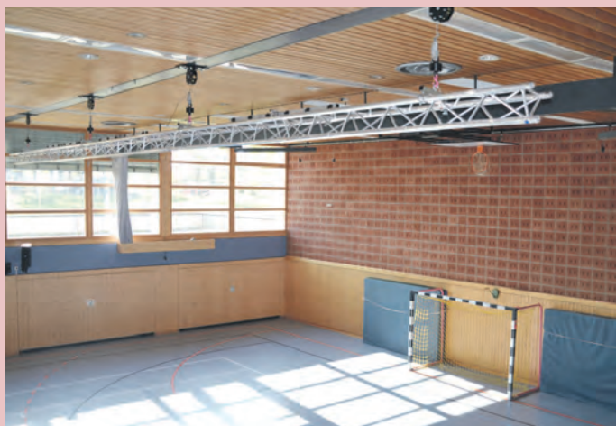
Eine neuer Träger unter der Hallendecke ermöglicht nun eine flexible Bühnenbeleuchtung.
