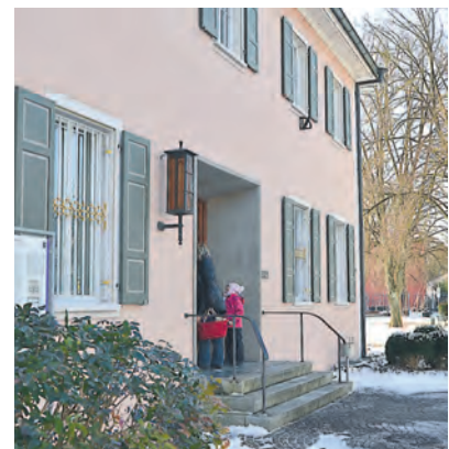
Altbau: Das ehemalige Rathaus soll nun barrierefrei hergerichtet werden.
