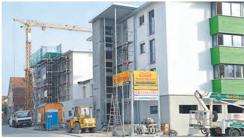
Kräftig gebaut wird derzeit in Engens Breite Straße. Neben Geschäften entstehen auch Eigentums- und Mietwohnungen, die sehr gefragt sind. swb-Bild: mu
