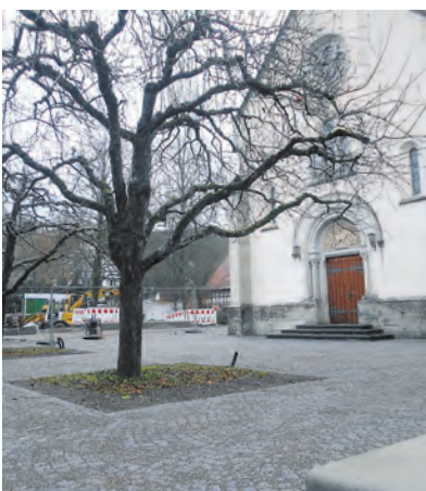
Die Umbauarbeiten am Dorfplatz Möggingen gingen bisher sehr zügig voran.
