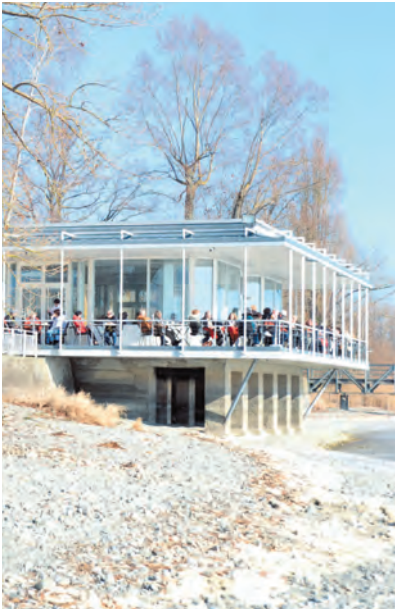
Im Strandcafé ist derzeit Großreinemachen angesagt: Bereits Anfang April sollen die ersten Besucher auf der neuen Terrasse Platz nehmen können. swb-Bild: gü
