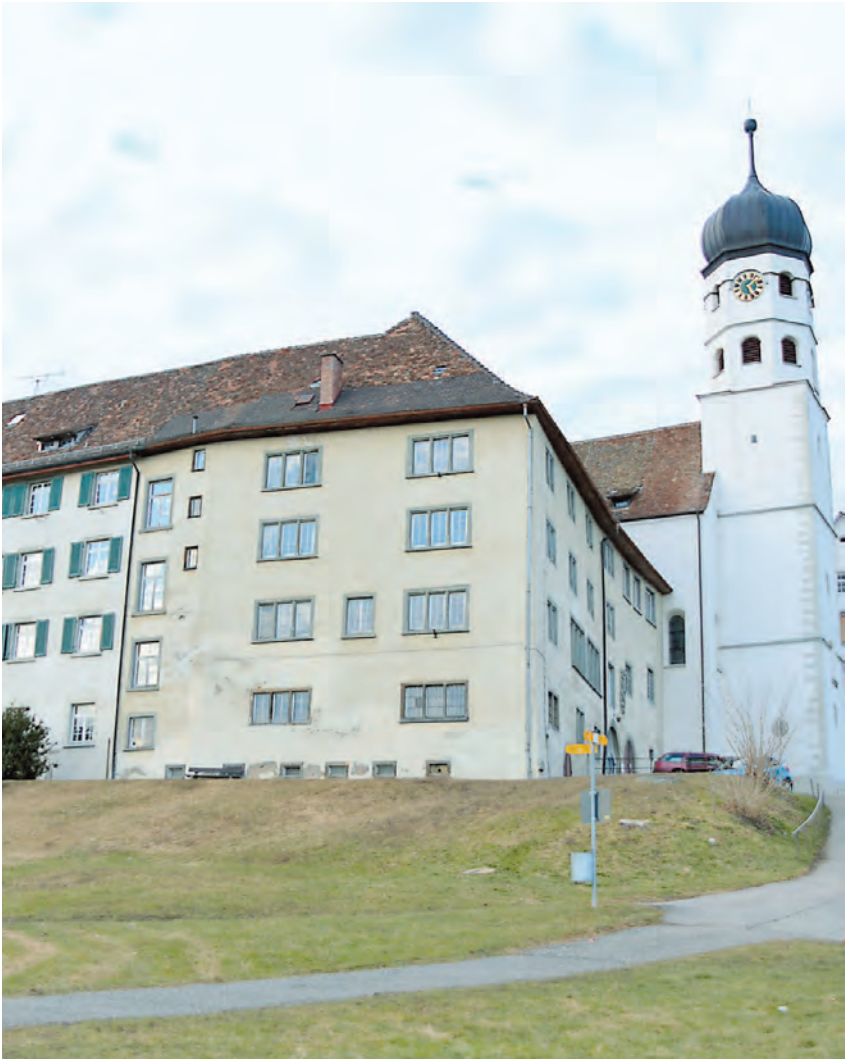
Langsam tut sich was im Öhninger »Augustiner Chorstift«: Der Gemeinderat gab den Startschuss für die Sanierung. Bereits Anfang kommender Woche sollen die ersten Bauarbeiten beginnen. Auf dem Dach und der statischen Sicherung des mittlerweile in die Jahre gekommenen Gebäudes liegt das Hauptaugenmerk im ersten Bauabschnitt. swb-Bild: gü
