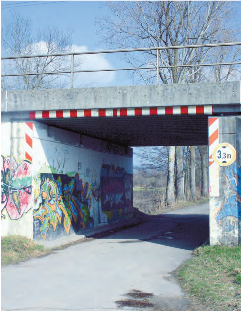
Bei Einsätzen während der Sperrung der Mooser Brücke kann die Radolfzeller Feuerwehr nur mit einem kleinen Löschfahrzeug und dem Führungsfahrzeug den Weg durch das Böhringer Ried benutzen. Alle anderen Löschfahrzeuge sind zu groß und zu schwer.
