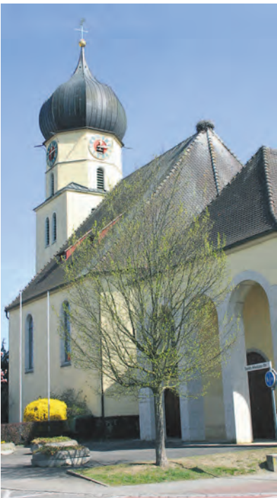
Die Böhringer Nikolauskirche muss renoviert werden. Die Gesamtkosten des Bauprojektes werden derzeit auf 898.000 Euro geschätzt. Baubeginn ist nach dem Weißen Sonntag.
