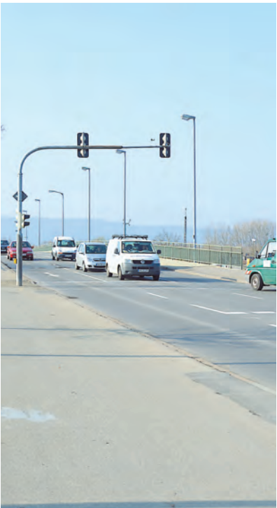
Die Sanierung an der Mooser Brücke hat begonnen: Einen ungehinderten Verkehrsfluss (wie hier auf dem Bild) wird es für die nächsten zehn Wochen nicht mehr geben. swb-Bild: gü
