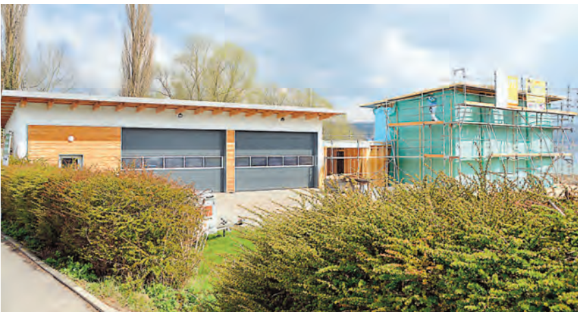
Am Ufer von Bodman entsteht die neue DLRG-Rettungswache. swb-Bild: Weiß
