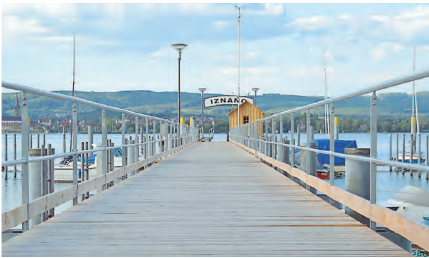
In neuem Glanz erstrahlt der Landungssteg in Iznang. Trotz neuem Geländer, Holzbohlen und frisch renovierten Wartehäuschen ist die Vorfreude bei manch einem Freizeitkapitän, ob dem Eigenanteil an den Sanierungsarbeiten, getrübt.
