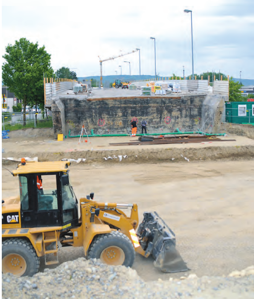
Knapp nach der Hälfte der Sperrzeit der Mooser Brücke ziehen die Verantwortlichen ein positives Fazit. Ob der Zeitrahmen der Bauarbeiten eingehalten werden kann, steht derzeit aber noch in den Sternen. swb-Bild: gü
