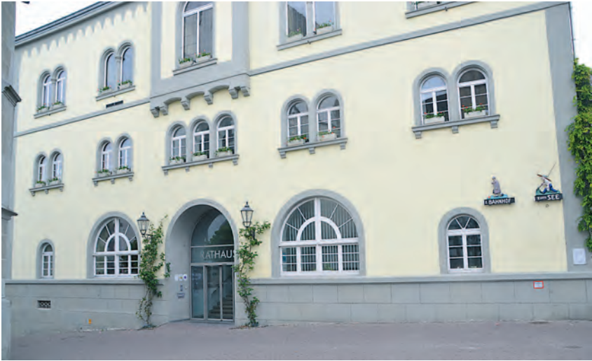
Äußerlich sind die Sanierungsarbeiten am Radolfzeller Rathaus nicht zu bemerken, doch im Inneren geht es heiß her: In den kommenden Wochen werden die Toilettenanlagen sowie der Fahrstuhl auf Vordermann gebracht. Zudem entsteht ein behindertengerechter Eingang. swb-Bild: gü
