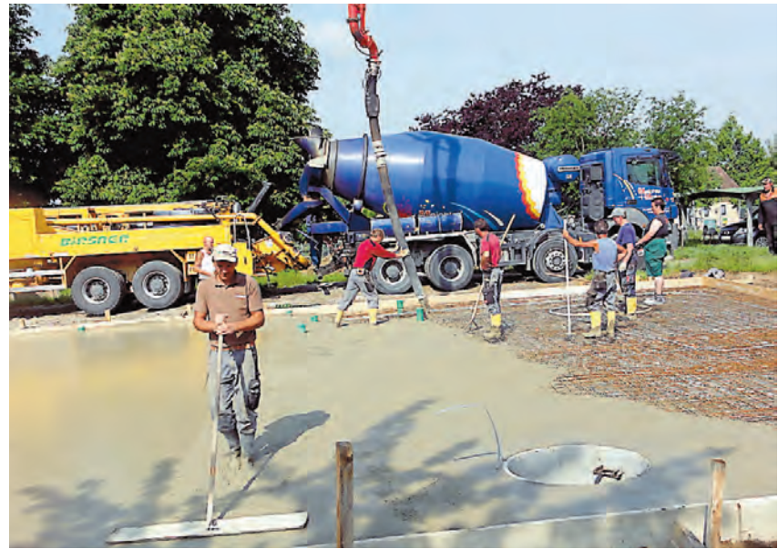
Die Arbeiten am neuen Musikhaus in Markelfingen schreiten zügig voran. Bereits am 20. August soll das neue Refugium des Musikvereins geliefert werden. Der Einzug soll dann Anfang November stattfinden. swb-Bild: privat
