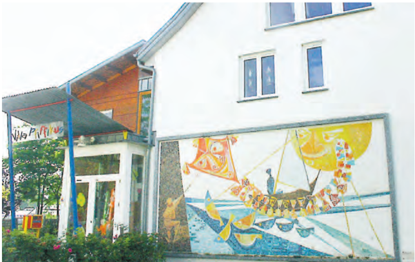
Der Kindergarten Moos braucht einen Anbau, um die gewünschten Plätze für die Betreuung der Unter-Dreijährigen gewährleisten zu können. Das Mosaik von Robert Seyfried an der Außenwand soll auf jeden Fall erhalten werden. swb-Bild: pud
