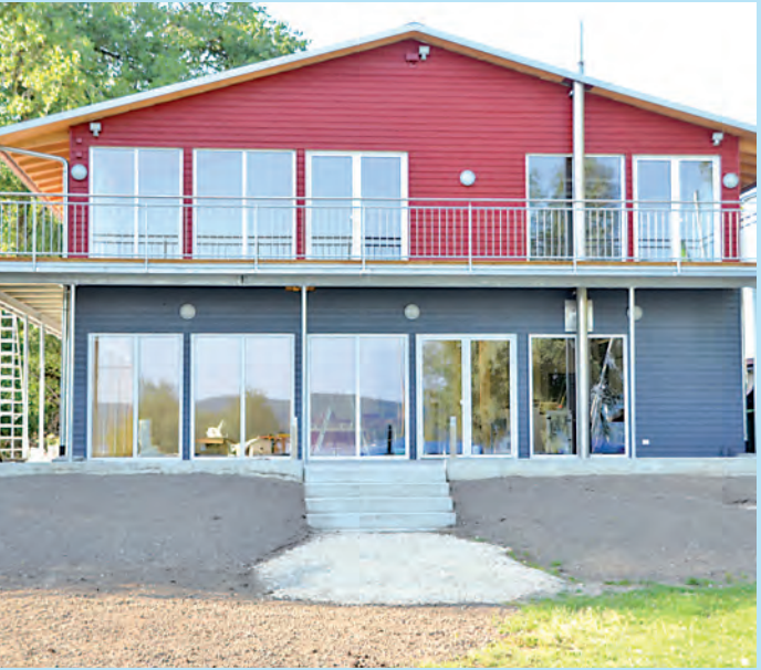
Auf einer Nutzfläche von stolzen 380 Quadratmetern werden neben Funktionsräumen für die Jugendausbildung eine kleine Werkstatt, eine Umkleide mit entsprechenden Sanitäranlagen, ein Segellager und eine Bootshalle im neuen Clubheim integriert.
